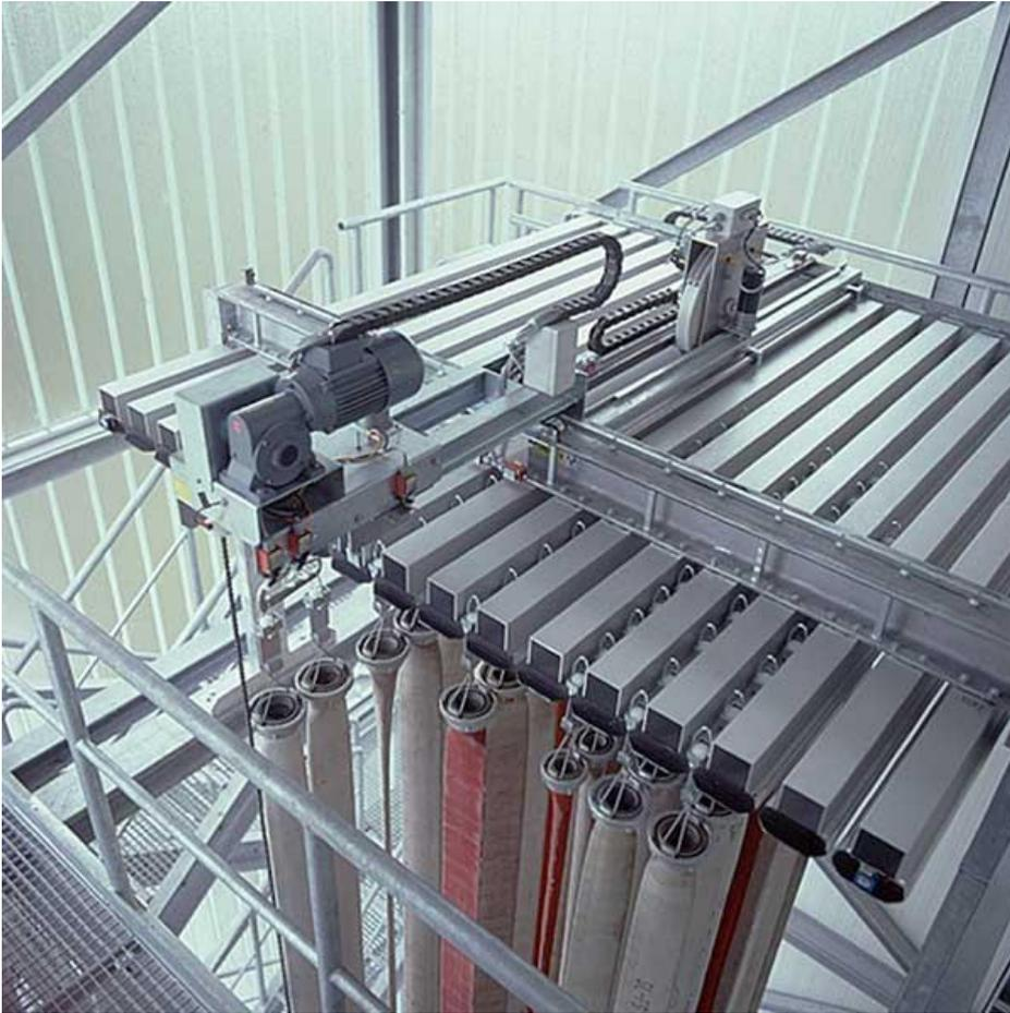
**Die flexibelste unter den automatischen Schlauch-Aufhängeanlagen mit zwei bis vierzig Bahnen und Bahnlängen bis zu vier Metern Länge für Große Berufsfeuerwehren und feuerwehntechnische Zentralen und Dienstleistungszentren mit konventionellen Schlauchpfeletürmen:**
