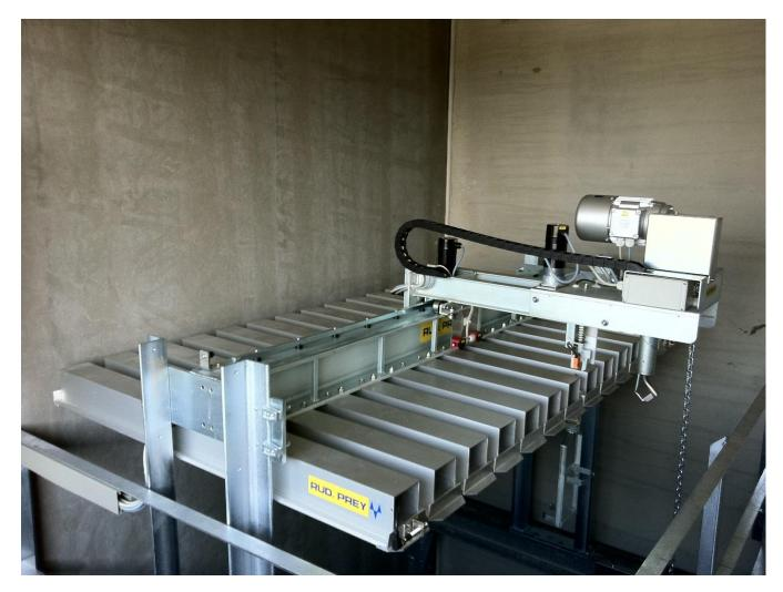
Das Original unter den automatischen Schlauch-Aufhängeanlagen mit ein bis zwanzig Bahnen für mittelgroße Feuerwehren mit konventionellen Schlauchpflegetürmen.
